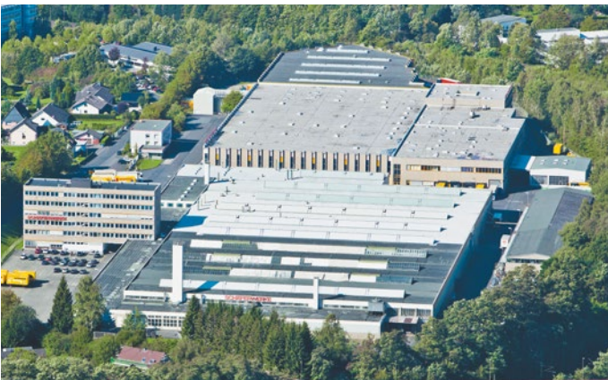
Plant in Betzdorf (D)
