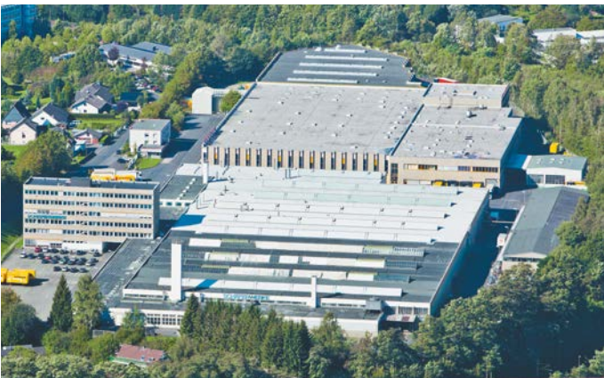
Plant in Betzdorf (D)
