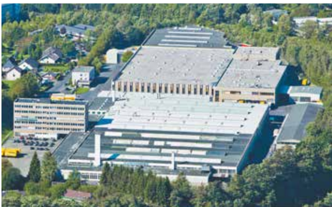
Plant in Betzdorf (D)
