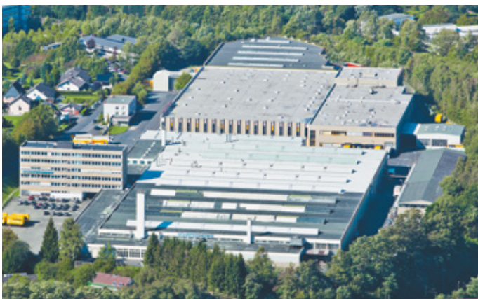
Plant in Betzdorf (D)
