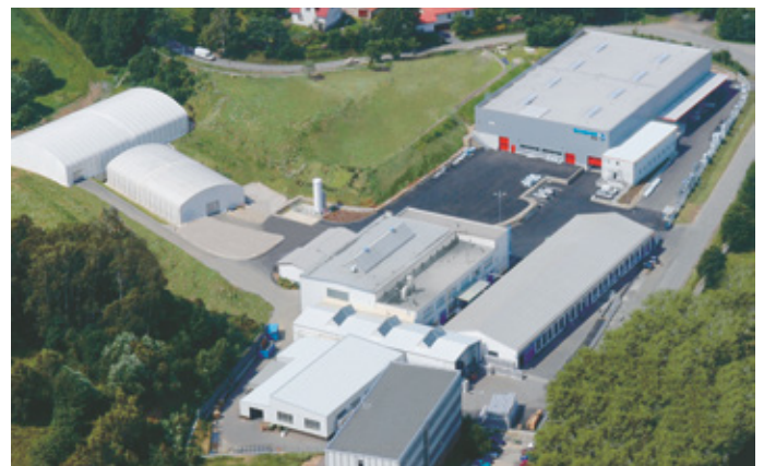
Plant in Ledeč nad Sázavou (CZ)
