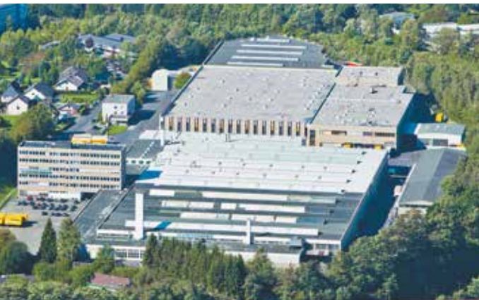
Plant in Betzdorf (D)
